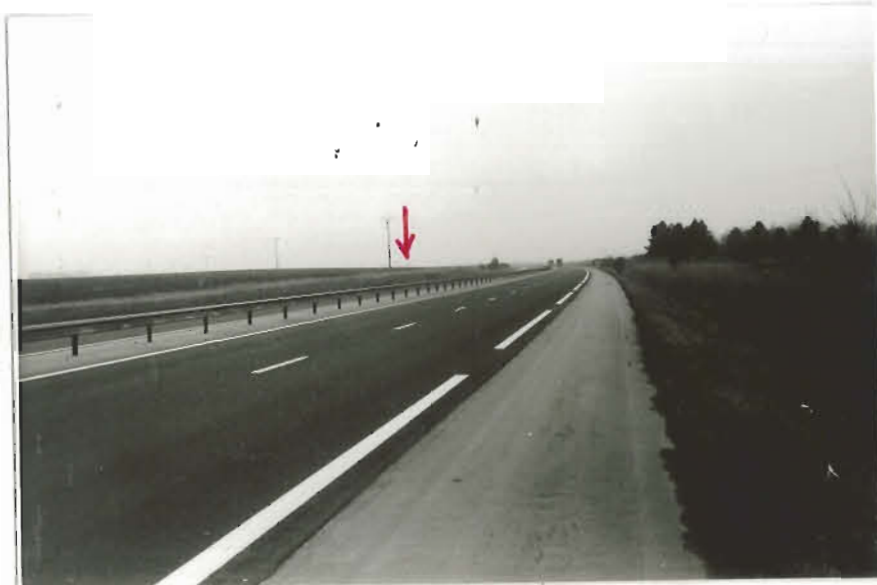
Cliché n° 2 : PK 62+500 Lieu d'où a été aperçu la première vers les arbres bordant le CD 927 à proximité du péage d'ALLAINES.
