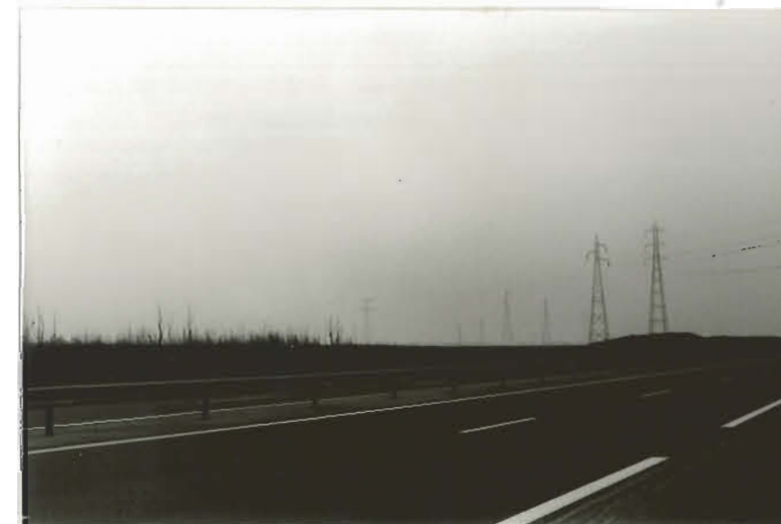
Cliché n° 6 : PK 73+600 Autres pylônes sur lesquels a été remarqué la lueur.
