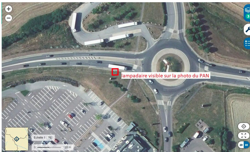
Figure 8 : localisation du lampadaire visible sur la photo du PAN (image : Géoportail)
