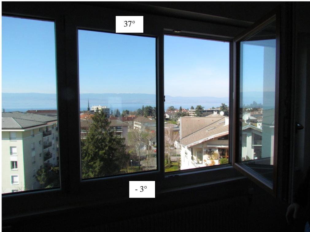
Mesures de la fenêtre : La fenêtre complète, composée de 4 vantaux dont 2 fixes de chaque côté + 2 ouvrants au milieu, mesure exactement 2,70 m de largeur et 1,27m de hauteur. L'ouvrant mesure précisément 1,31m de largeur sur 1,10 m de hauteur. Le mur de la chambre mesure 3,78 m.
